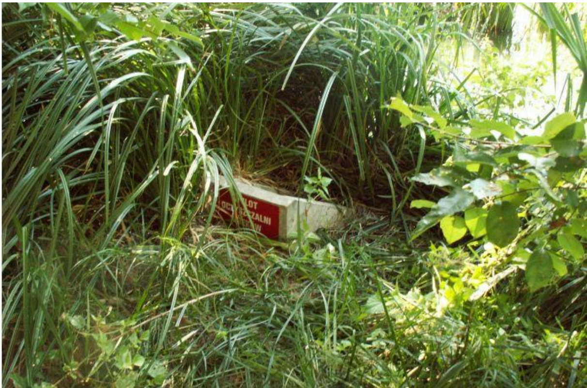
Fot. 12 Wylot ścieków oczyszczonych do odbiornika.
