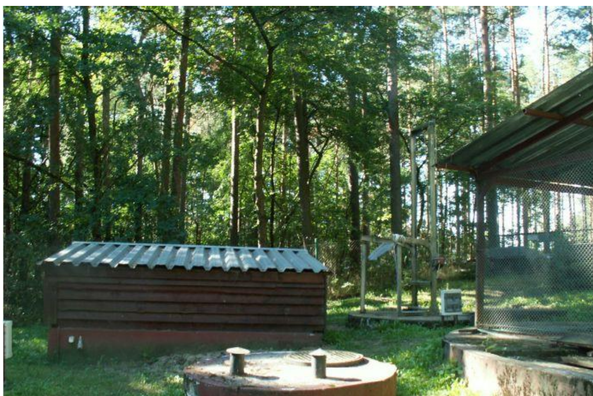
Fot. 6 Plan pierwszy – przepompownia, plan drugi – osadnik wstępny.
