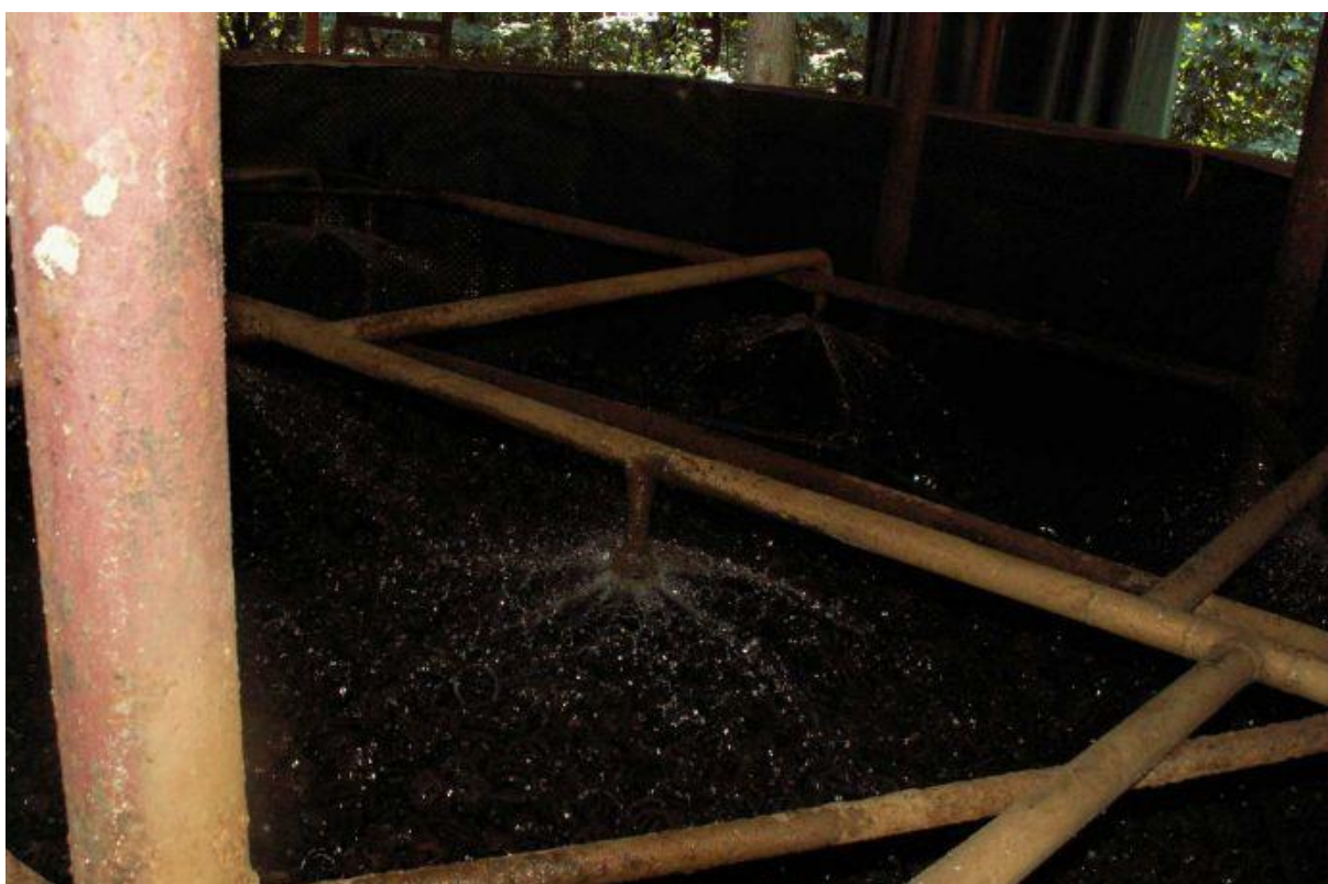
Fot. 8 Rozprowadzenie ścieków na złożu.
