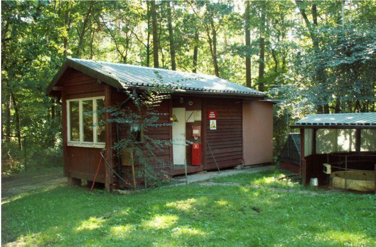
Fot. 11 Budynek techniczny.
