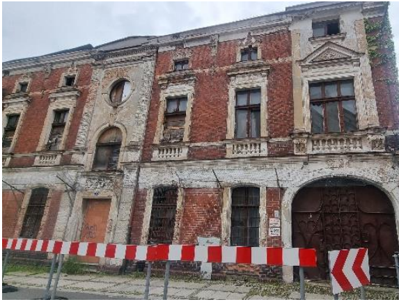
Fot. Widok na elewację frontową
