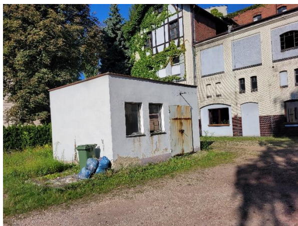
Fot. Widok budynek przepompowni oleju
