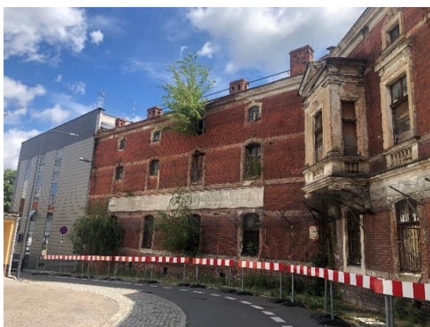
Fot. Widok na elewację frontową
