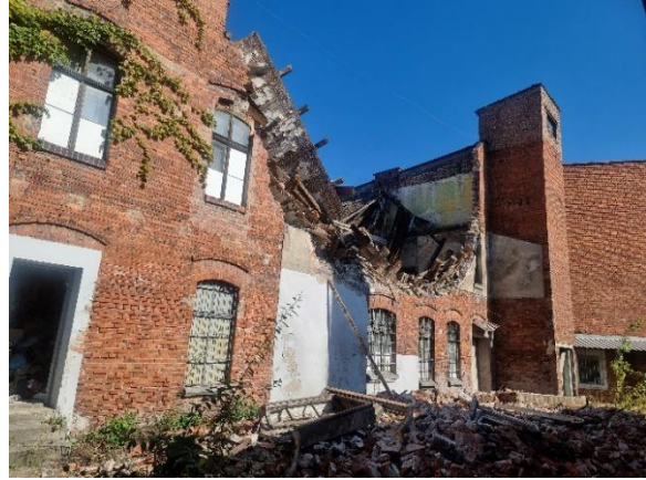
Fot. Widok na elewację tylną
