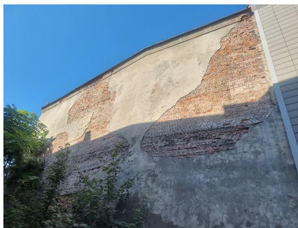
Fot. Widok na elewację tylną
