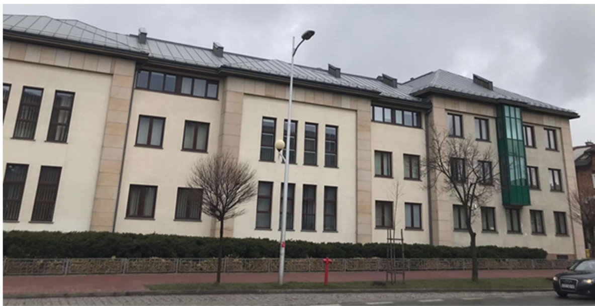
Widok na elewację południową
