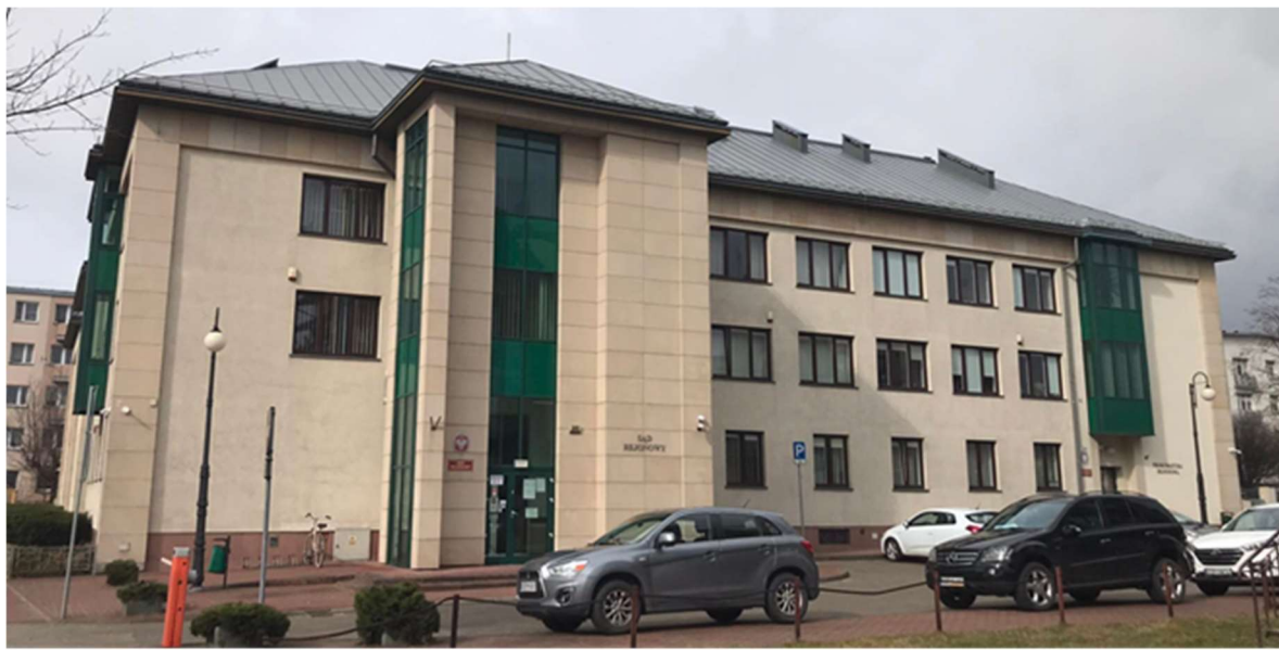
Widok na elewację wschodnią
