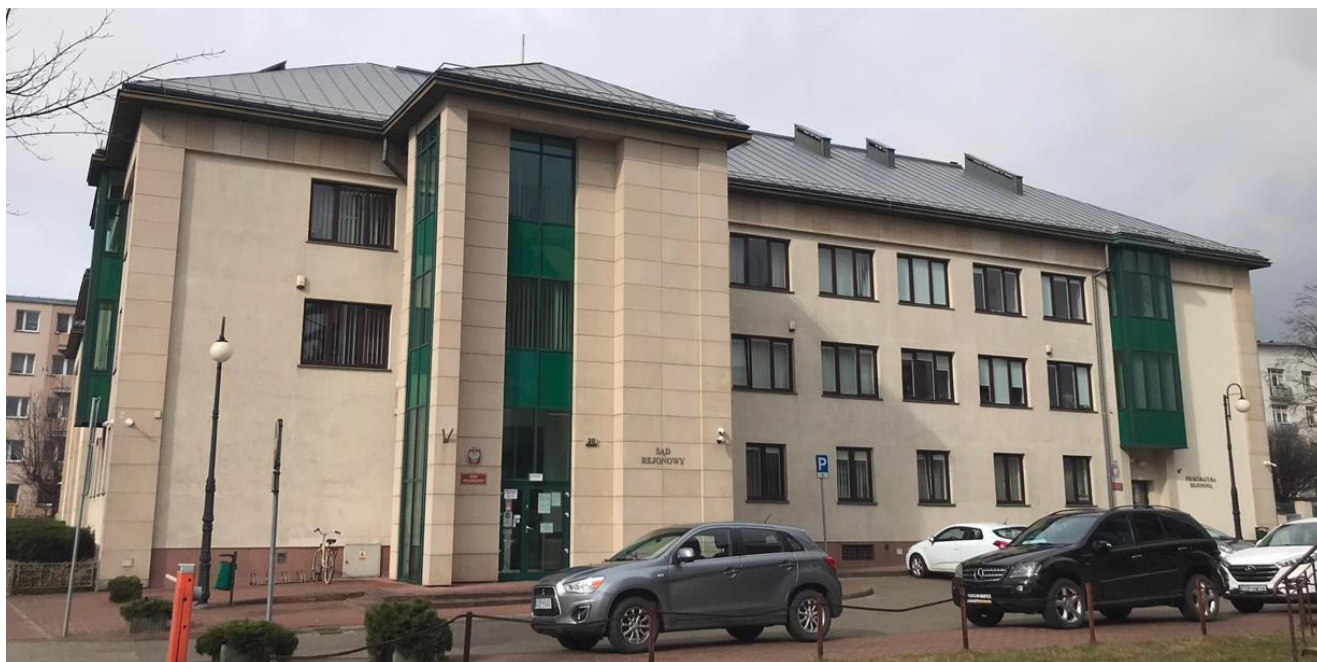
Widok na elewację wschodnią.
