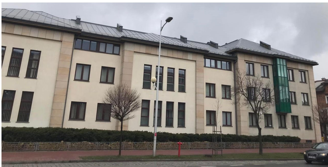
Widok na elewację południową.
