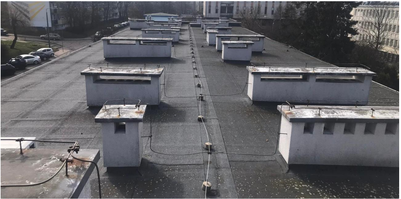
Widok na dach segmentu południowego ( budynek Prokuratury Rejonowej )
