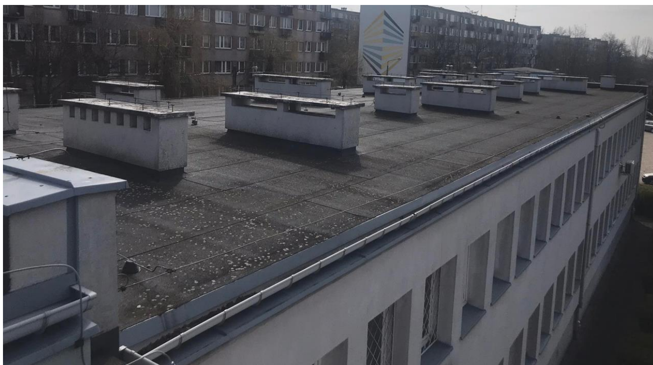
Widok na dach segmentu południowego ( budynek Prokuratury Rejonowej )
