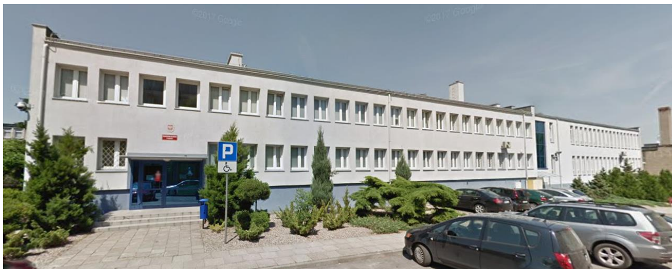
Widok na elewację wschodnią od strony wejścia głównego do Prokuratury Rejonowej.
