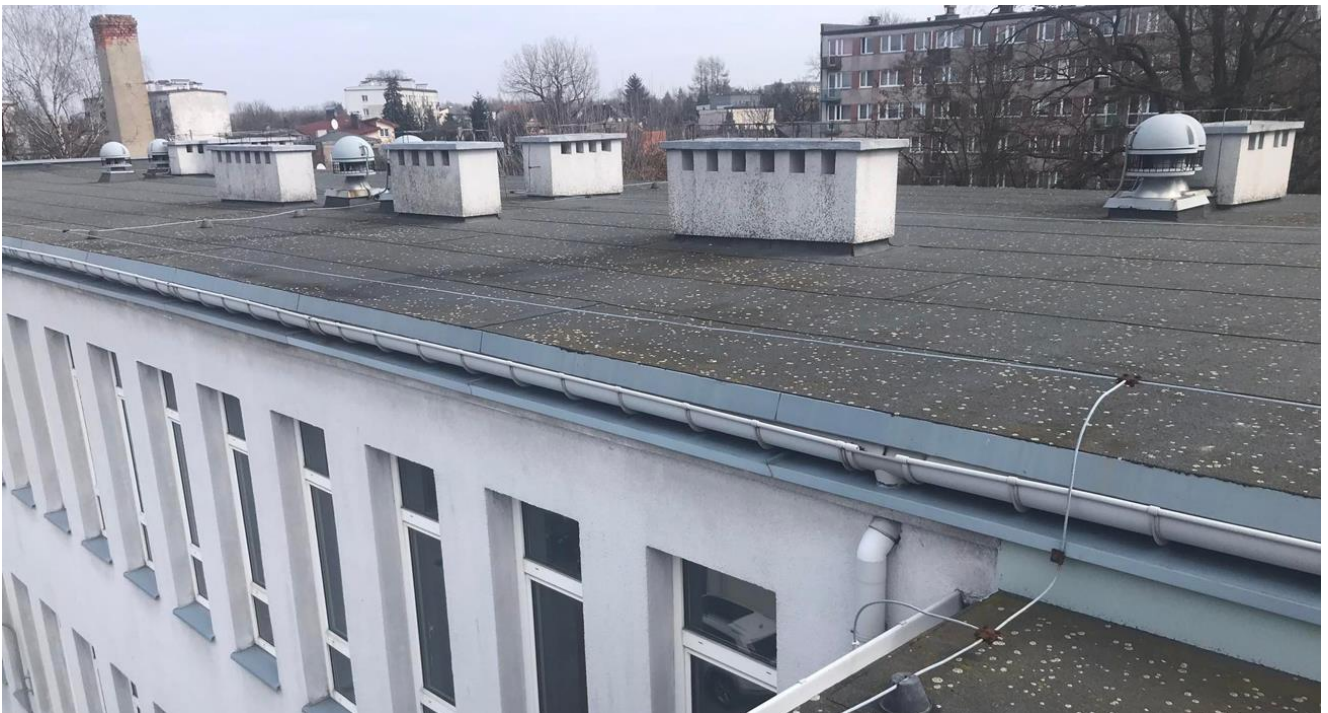
Widok na dach segmentu północnego ( budynek Prokuratury Rejonowej )
