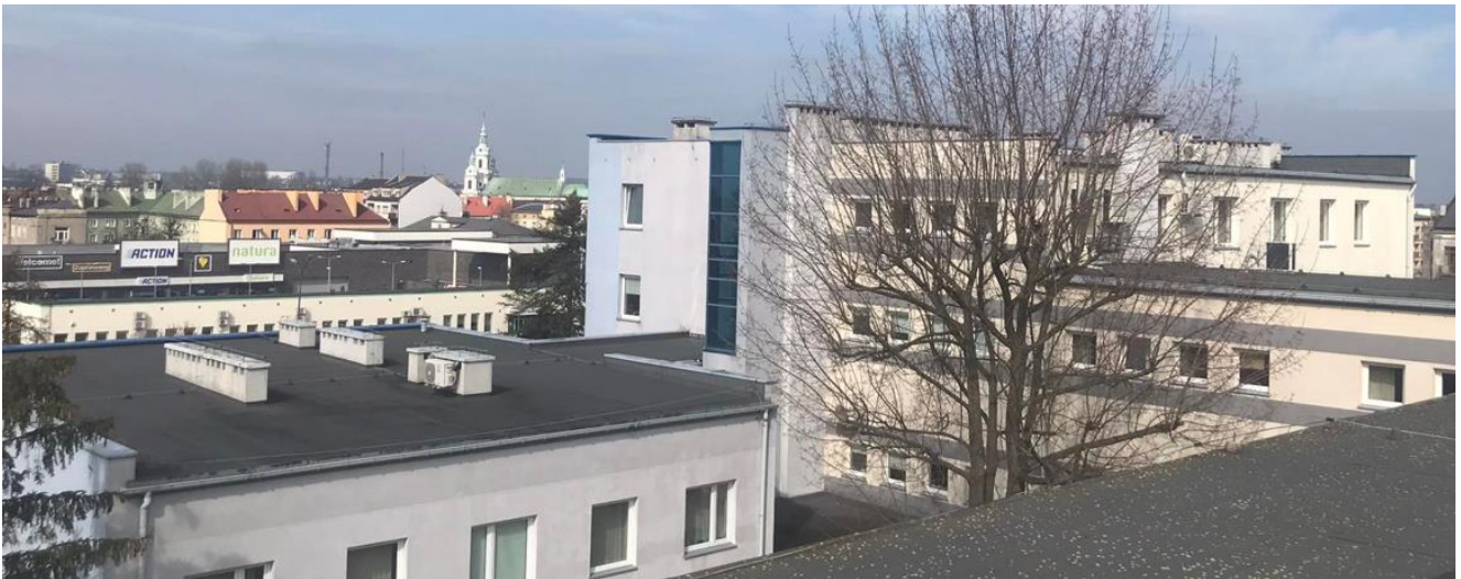
Widok na dachy budynku Sądu Rejonowego
