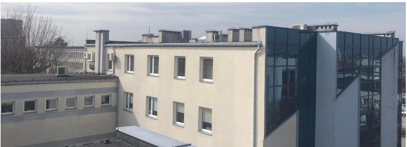
Widok na dachy budynku Sądu Rejonowego
