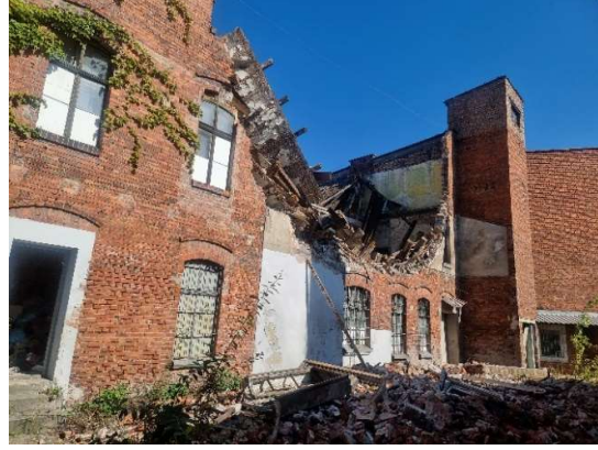
Fot. Widok na elewację tylną
