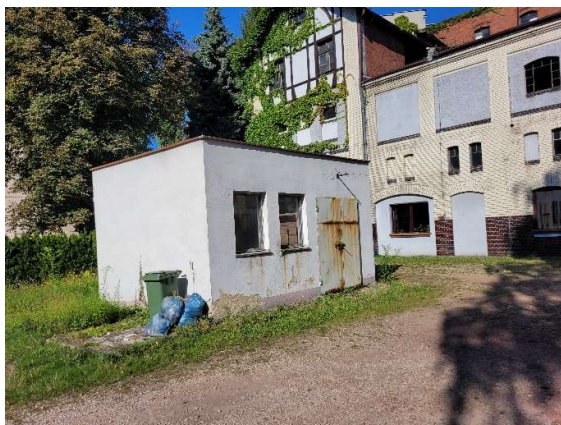
Fot. Widok budynek przepompowni oleju
