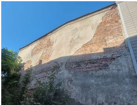
Fot. Widok na elewację tylną
