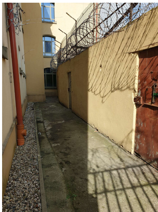
Mur zewnętrzny placu spacerowego przy Pawilonie A
