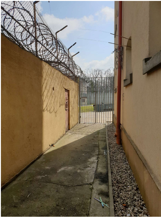
Mur zewnętrzny placu spacerowego przy Pawilonie A
